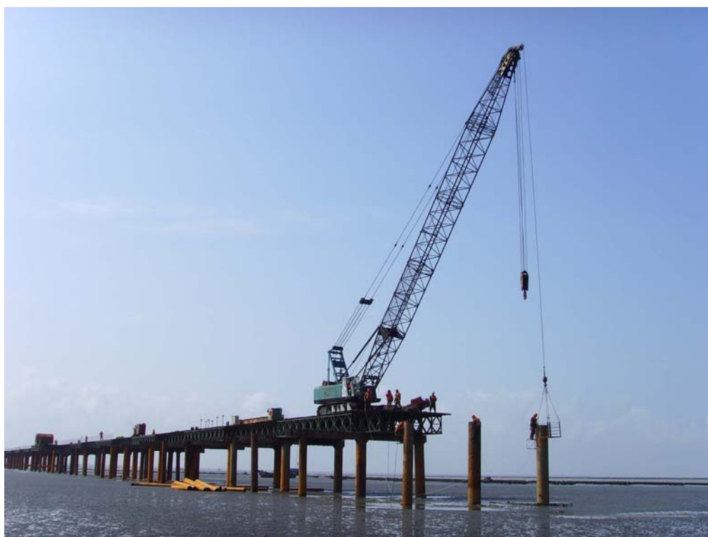
建設中的黃海大橋
